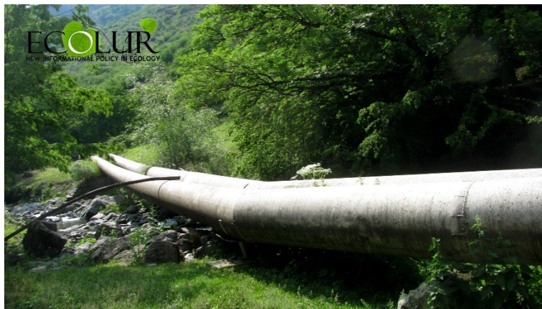
Նկար 13. Փոքր ՀԷԿ-ի վերգետնյա խողովակաշարերը՝ «Դիլիջան» ազգային պարկում
