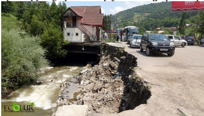
Նկար 7. Դիլիջան քաղաքում ճանապարհահատվածի փլուզում ջրհեղեղի հետևանքով
